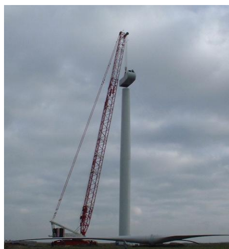
Montage de la nacelle
