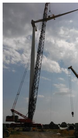
Montage du rotor pale par pale
